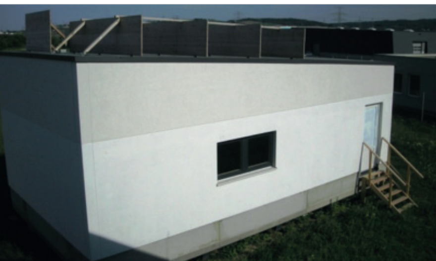
Forschungshaus der Holzforschung Austria an ihrem zweiten Standort in Stetten mit Dachaufbauten
