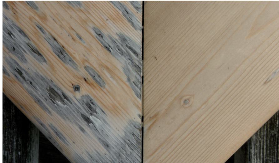
Handlaufecke nach 2 Jahren Freilandbewitterung: links ohne, rechts mit Wartung
